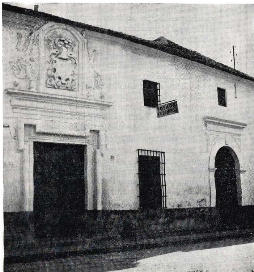
Estado actual de la casa de los Gutiérrez Quijada, de cuya alcurnia descendía Alonso de Ayllón. (Calle de Santo Domingo)
