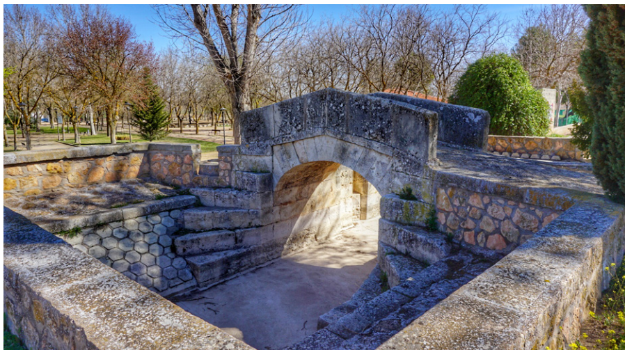
Figura 31. Puente en Alameda de Cervera perteneciente al Canal del Gran Prior. Imagen del autor.
