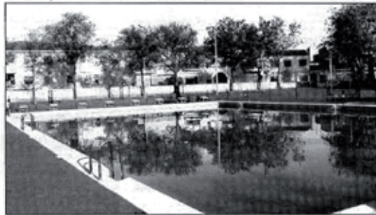
El nuevo vaso está instalado junto al resto de piscinas municipales, la de 50 metros y la de niños además de la cubierta. La inversión ha ascendido a 25 millones de ptas. de los que 10 ha puesto el Ayuntamiento y 15 la Junta de Comunidades
