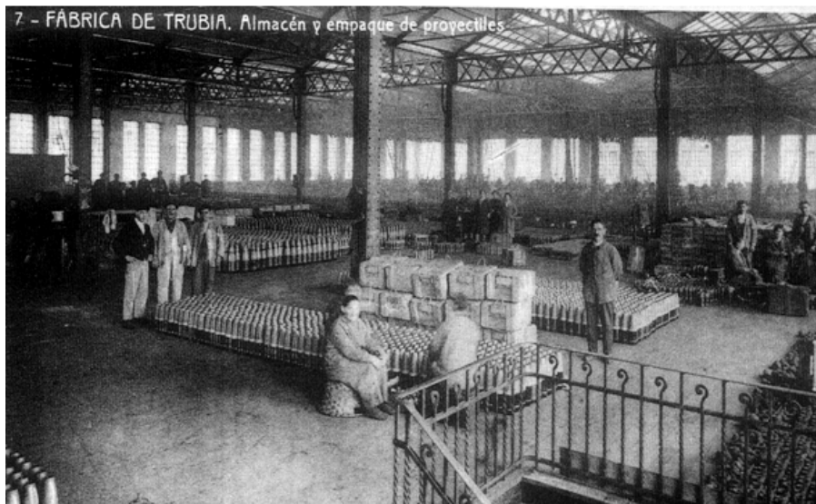
Fabrica de Trubia 27 (Oviedo). Almacén de proyectiles de Artillería.
