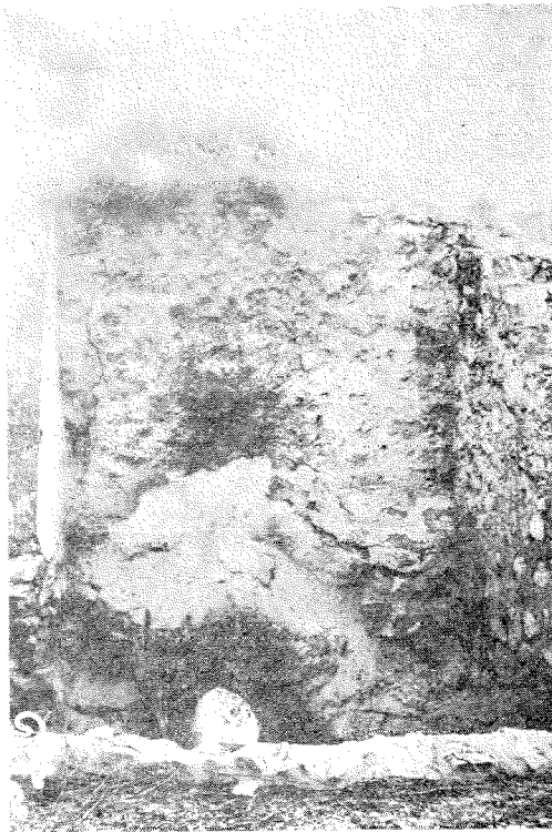
El barranco y la boca del horno. El medio punto de la parte inferior es la boca y la claridad que se aprecia en su fondo es debida a las llamaradas de las gavillas que arden.
