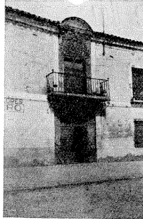
Fachada de la casa de Pantoja, en la Plaza.
