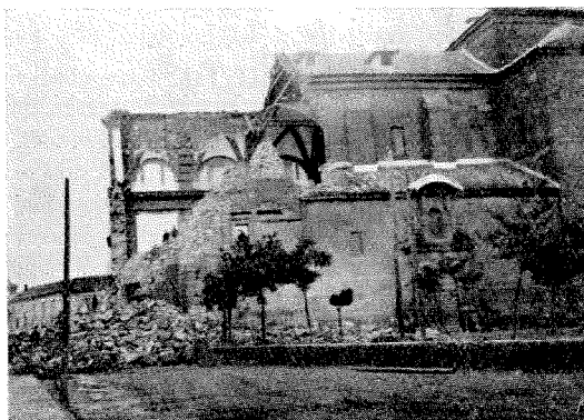
Vista exterior de Santa Quiteria, tomada desde la glorieta el día que se hundió la torre.
